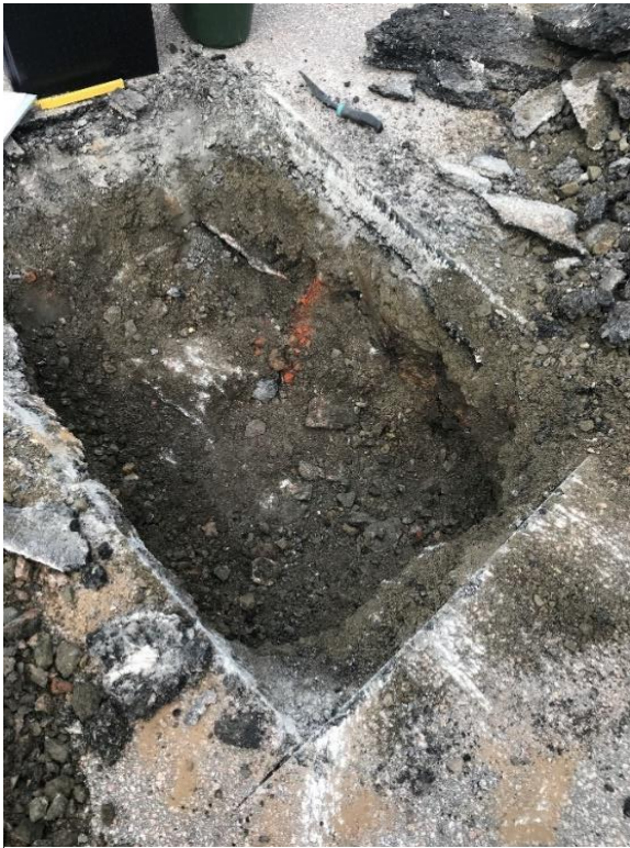
Figur 3. Jordprovtagning i provpunkt 2001. Dubbla lager av asfalt direkt under markytan.
